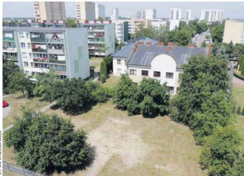
Teren przeznaczony do rewitalizacji
