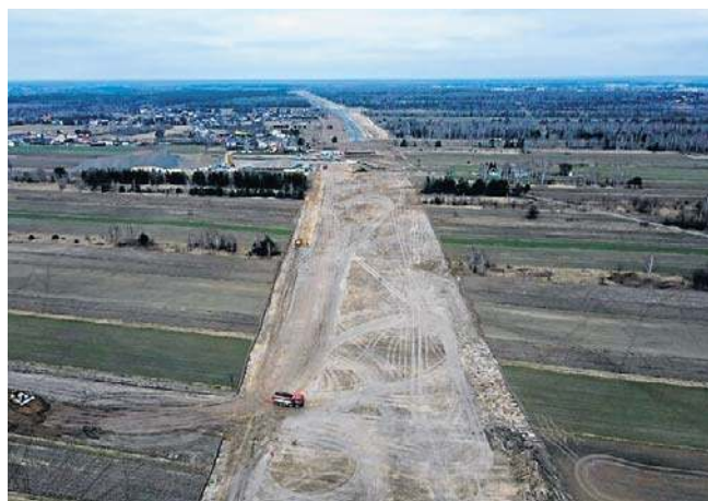
To element budowy trasy S19. Inwestycja na odcinku Lublin - Lubartów ruszyła w grudniu ub.r.
