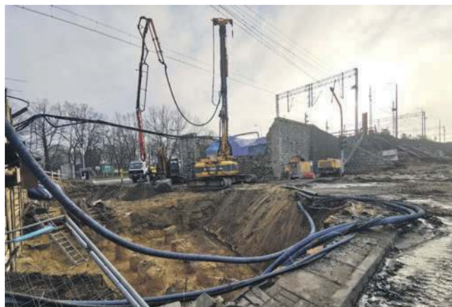
Przebudowa wiaduktu nad ul. Sienną
