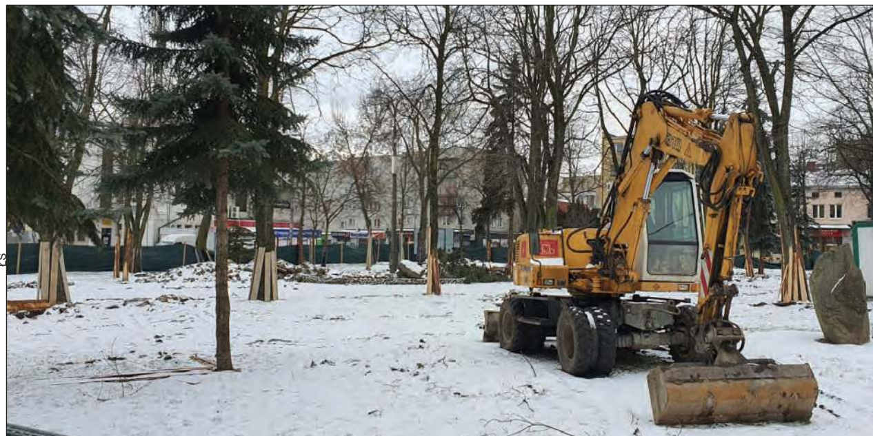
Po zakończeniu prac archeologicznych ruszą dalsze prace ziemne na skwerze
