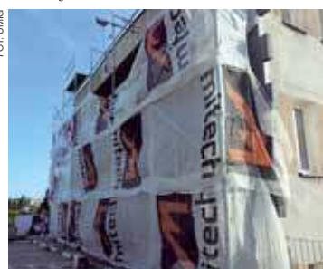
Remont kosztować będzie ponad 2 mln zł
