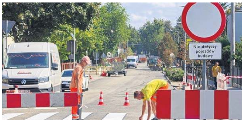
Remont Żwirki i Wigury jest na finiszu
