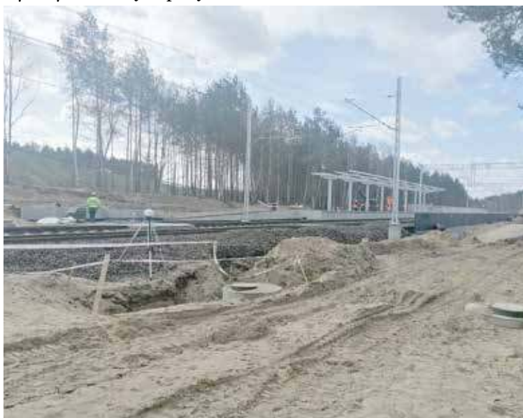
Prace na przystanku są bardzo zaawansowane, perony gotowe, widoczne też konstrukcje wiat
