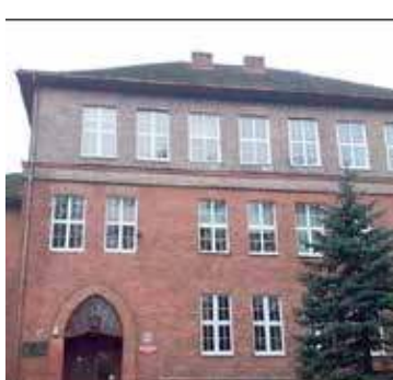
Budynek w SP w Maszewie doczeka się nowego dachu i orynnowania
