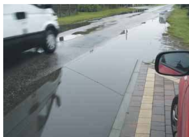
Ul. Główna w Zendku od lat nie była kompleksowo remontowana, łatano tylko dziury
