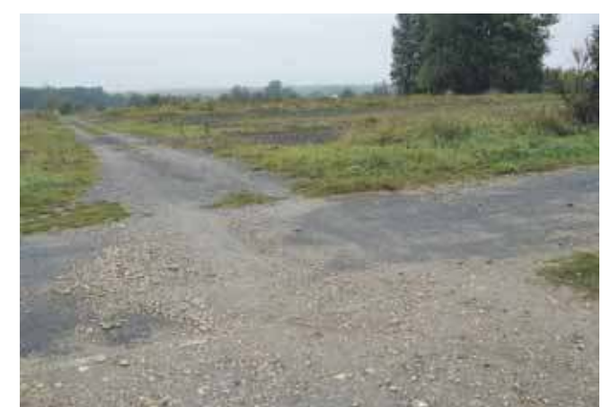
Na budowę ulicy równoległej do ul. Głównej na razie nie ma widoków. Wciąż część mieszkańców nie chce oddać swoich działek pod nową drogę
