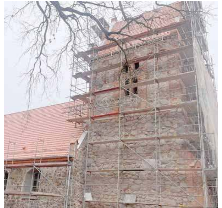
Świątynia w Sądowie przechodzi modernizację
