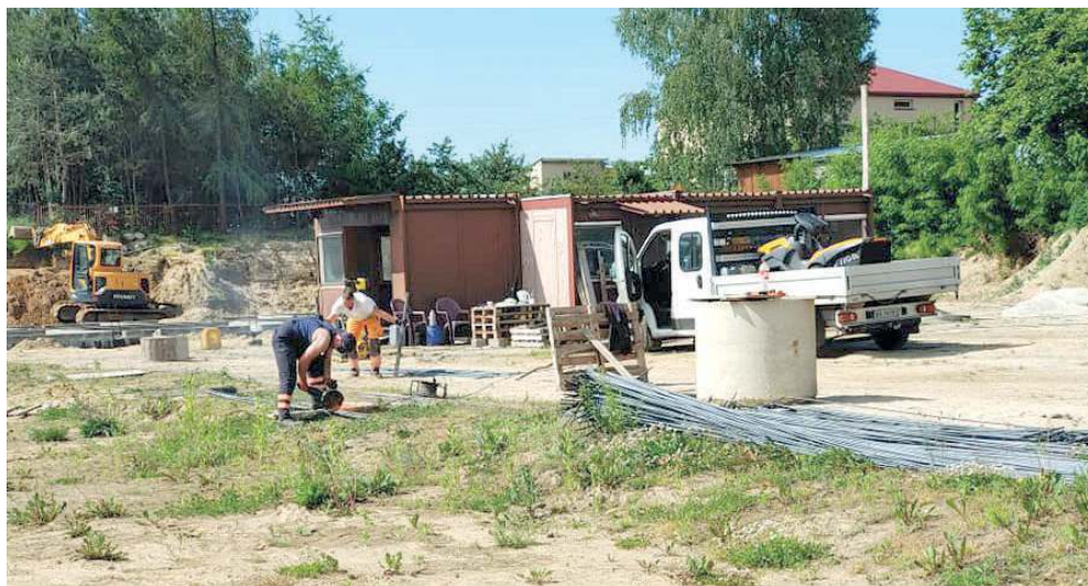
Firma Tel-Bruk prace zaczęła od wykonania muru oporowego, wokół którego będą budowane m.in. zadaszone trybuny na 250 osób. W tym roku ma zamiar wybudować budynki zaplecza, czyli szatnie, toalety oraz stałą, zadaszoną scenę o wymiarach 8 x 20 metrów
