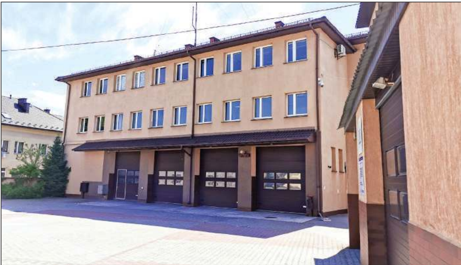
Od maja budynek po byłej komendzie straży przy ulicy Warszawskiej stoi pusty. Czekają na nowych użytkowników
