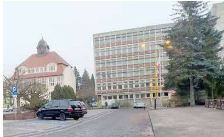
Budynek Cisy z pewnością nadaje się do remontu, ale problemem są jak zawsze fundusze, a w zasadzie ich brak
