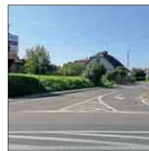
W ramach przebudowy zaplanowano m.in. budowę wyspy dzielącej ul. Łomaską
