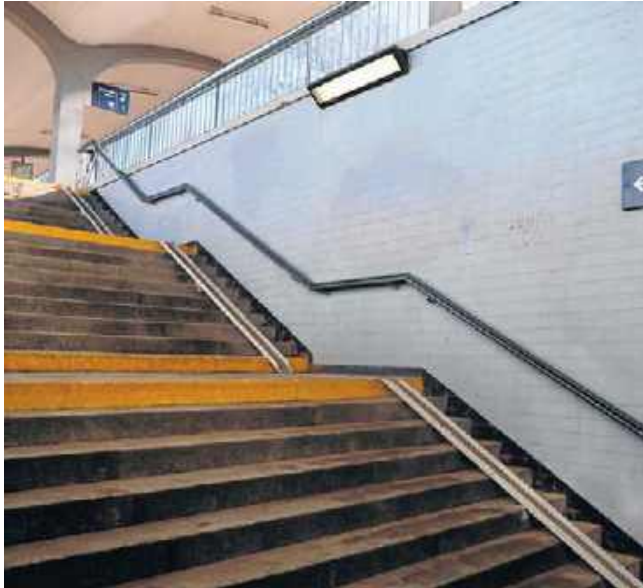
Zarówno na peron, jak i do przejścia podziemnego prowadzą strome schody z jedną szyną dla rowerów
