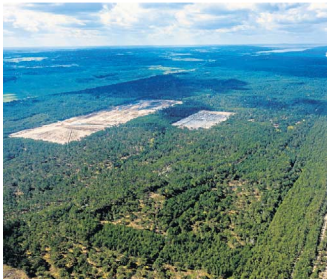
Teren przyszłej pierwszej elektrowni atomowej w Polsce Lubiatowo - Kopalino
