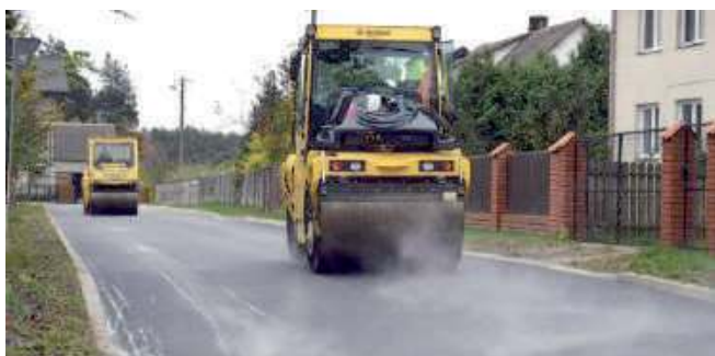
Budowa nawierzchni asfaltowej na osiedlu w Sarnowie
