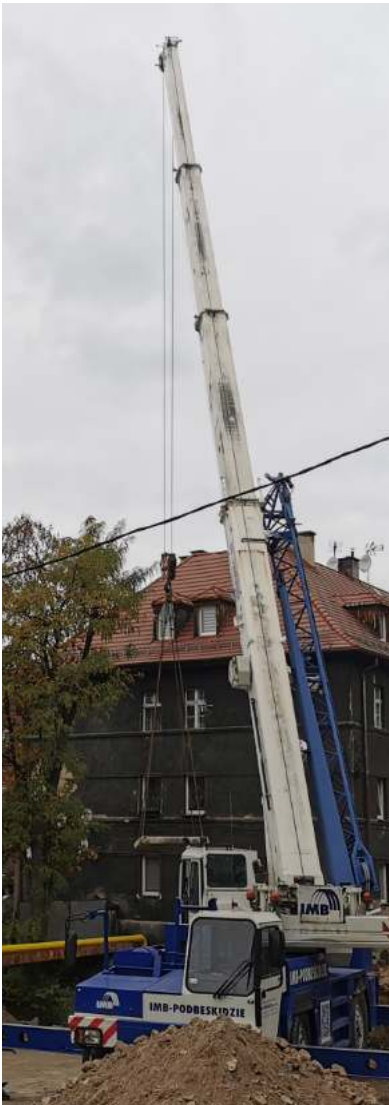
Ruszyła przebudowa mostu nad Bytomką wzdłuż ulicy Jagiellońskiej.
