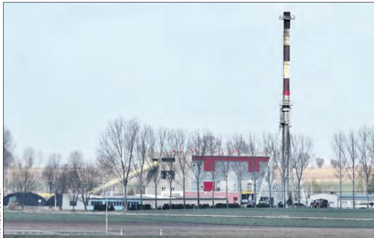
Punkt odbioru węgla dla mieszkańców gminy Prudnik znajdować się będzie przy ciepłowni ZEC-u
