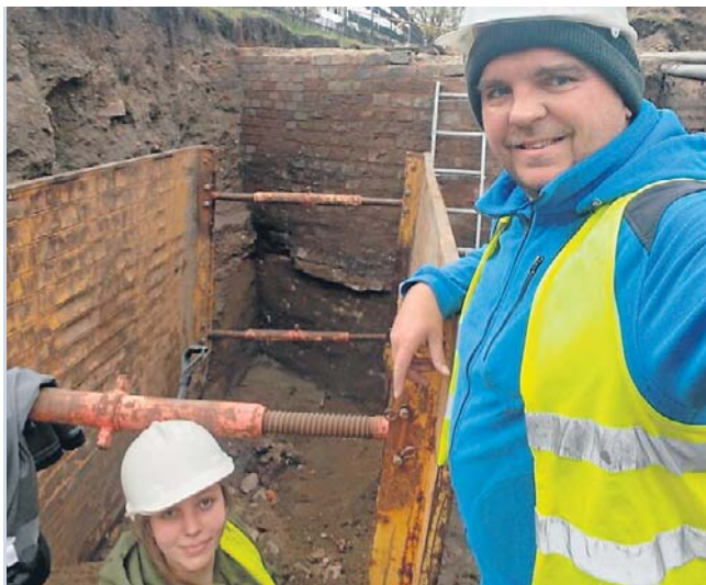
Archeolodzy chcą dotrzeć do samej podstawy konstrukcji bastionu
