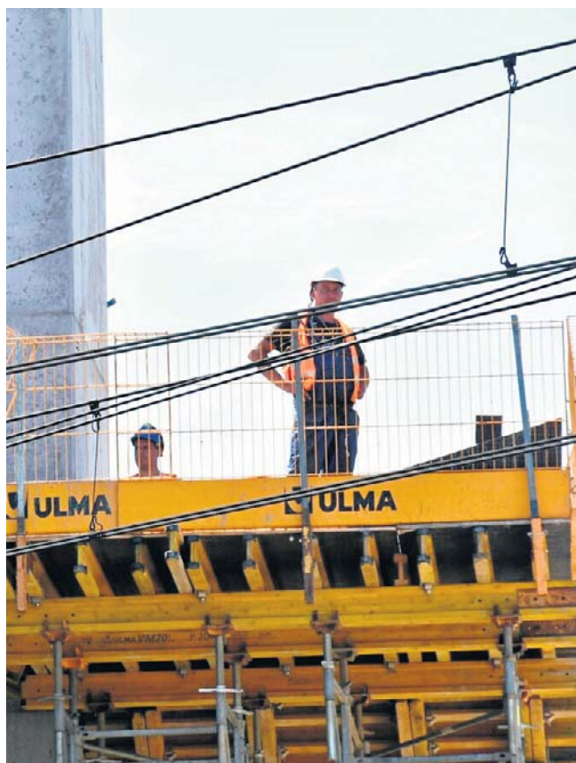
Budowa wiaduktu idzie zgodnie z harmonogramem
