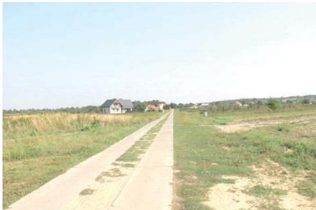
Pod koniec przyszłego roku na drodze łączącej Skowieszyn z Puławami zamiast płyt betonowych mieszkańcy będą mieli do dyspozycji nowiutki asfalt
