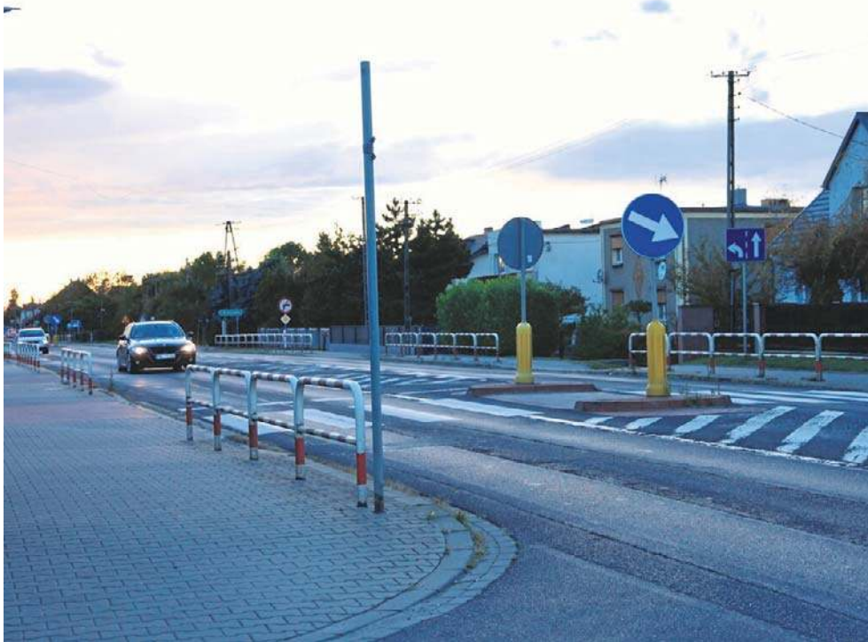
Przebudowa DK32 w Granowie to długo wyczekiwana inwestycja
