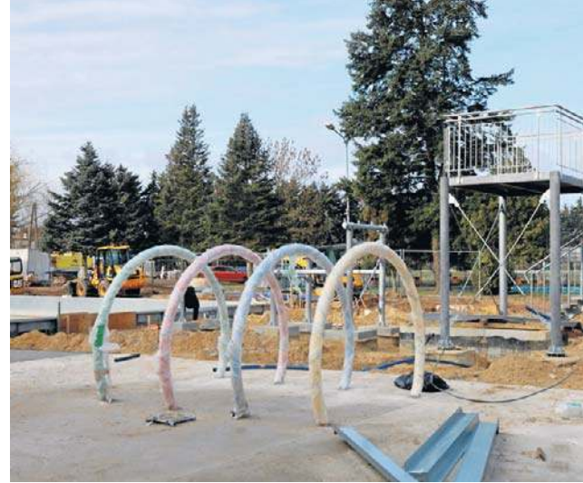
Prace przy nowym basenie wkraczają w kluczową fazę
