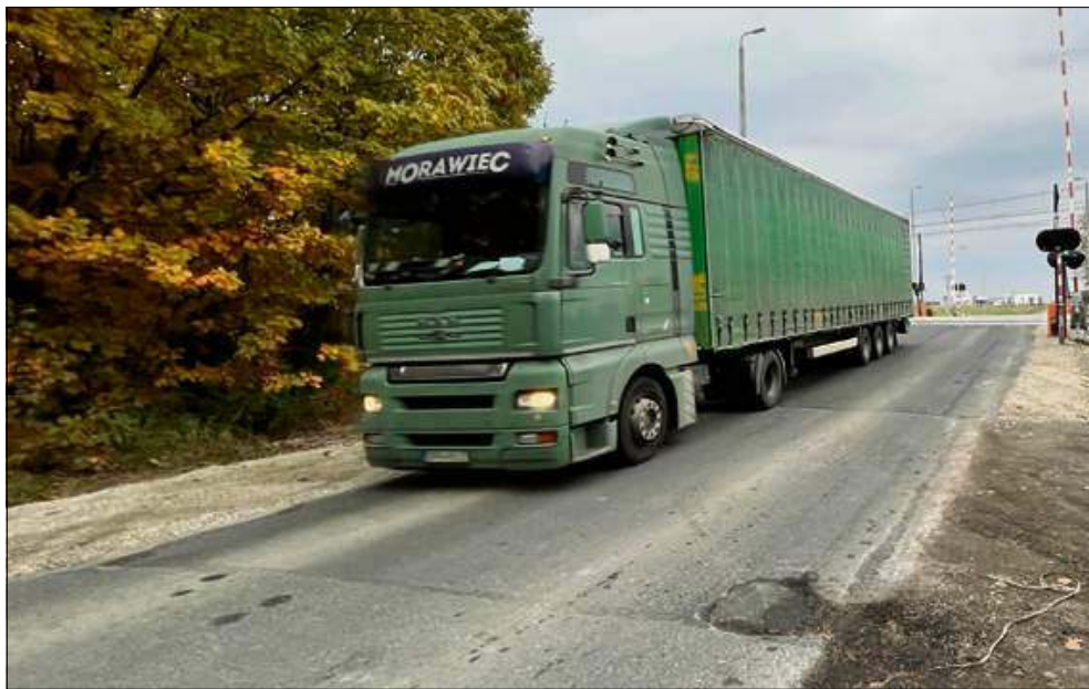
Pomiędzy zmodernizowanymi odcinkami drogi pozostał dziurawy odcinek „ziemi niczyjej”.
