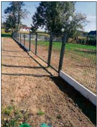
W Zabierzowie zostało zamontowane nowe ogrodzenie.
