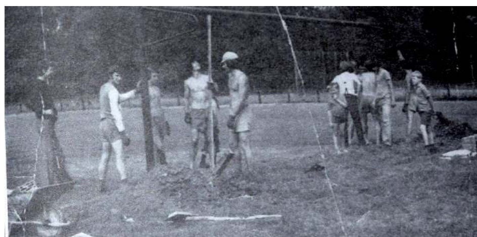
„Przy budowie nowego stadionu zupełnie społecznie pracowali zawodnicy klubu oraz wielbicieli sportu, a piłki nożnej w szczególności. Gdy pod koniec września 1965 roku stadion został oddany do użytku, nie było końca pochwał pod adresem klubu, zakładu i całego społeczeństwa Gminy Milejów. To był prawdziwy stadion, pięknie położony nad rzeką Wieprz, otoczony dużymi drzewami, o równej, świetnie utrzymanej płycie pełnowymiarowego boiska z zapleczem, krytą trybuną na 200 miejsc, kilkoma rzędami ławek, a całość utrzymana w porządku oraz czystości. W takiej sytuacji w ogóle nie dziwi fakt, że właśnie w Milejowie regularnie odbywały się zgrupowania kadry młodzieżowej reprezentacji województwa lubelskiego” - pisze Jacek Kosierb
