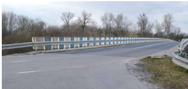
Most i droga pomiędzy Borową a Dęblinem zostanie zmodernizowany. W tym miejscu ma powstać także ścieżka pieszo-rowerowa i oświetlenie uliczne
