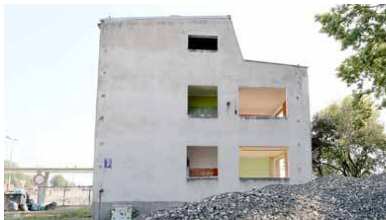
Zaczęto rozbierać budynek służący niegdyś jako mieszkania dla pracowników kolei. Na zdjęciu hałda zdartej nawierzchni asfaltowej z rampy od strony ul. Pułaskiego
