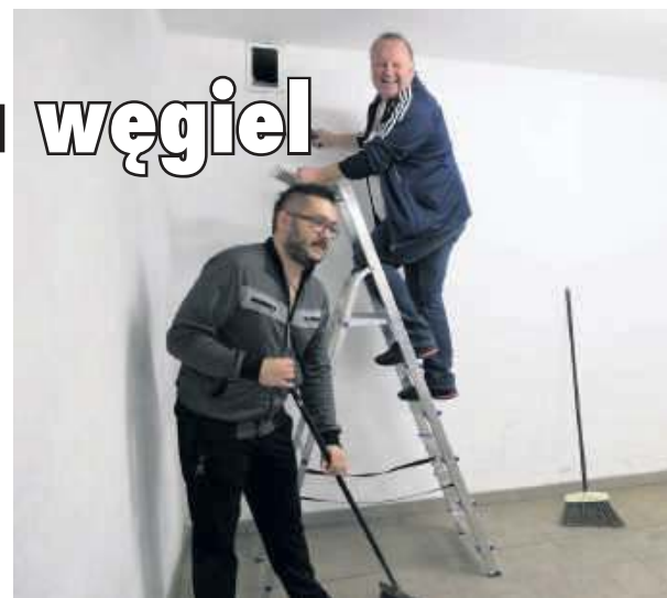
Pomieszczenie, które do tej pory było składzikiem na węgiel, zostało wysprzątane i przygotowane do dalszych prac remontowych przez pracowników Strzelińskiego Ośrodka Kultury. Na zdjęciu Damian Serwicki i Jacek Kramarz
