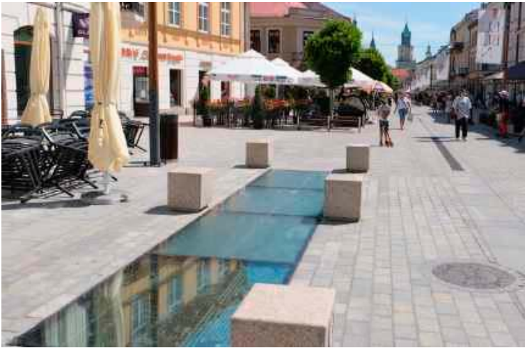
Trzy szyby wciąż pozostają niewyczyszczone, ogrodzenia wciąż brak
