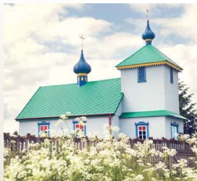
Cerkiew św. Jana Chrzciciela znajduje się po prawej stronie drogi z Kodeńca do Uhni-na. Kilka lat temu zakończono poważny remont, który nadał świątyni wręcz bajkowy wygląd. Wrażenie to pogłębia też uroda kamiennych, zupełnie innych od bezdusznego lastryku, ponadstuletnich nagrobków na otaczającym świątynię cmentarzu
