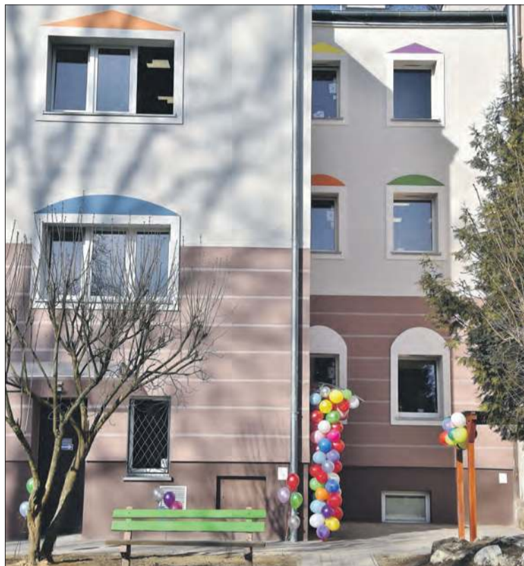
Nietypowo odnowiony fragment elewacji budynku przedszkola od strony ogrodu
