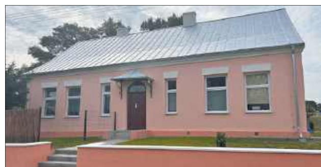
Właśnie dobiegły końca prace remontowe przedwojennego budynku z lat 20. XX wieku, dawnego urzędu gminy, a obecnie domu komunalnego. Tak prezentuje się obecnie
