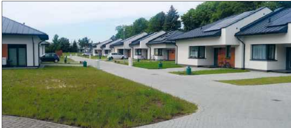
W 2024 zakończono projekt obejmujący budowę 15 mieszkań komunalnych w zabudowie szeregowej na terenie gminy Rossosz
