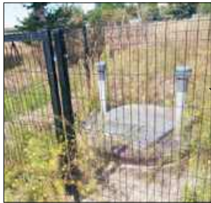
Strategicznym wyzwaniem na najbliższe lata pozostaje budowa oczyszczalni ścieków
