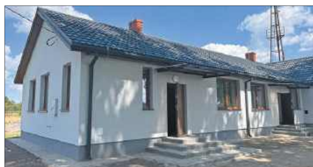
Kolejnymi budynkami, które w tym roku przechodzą odnowę są świetlice w miejscowościach Lubenka oraz Korczówka
