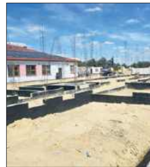
Rozbudowa ZOL-u polega na dobudowaniu nowego obiektu o powierzchni ponad 2300 mkw
