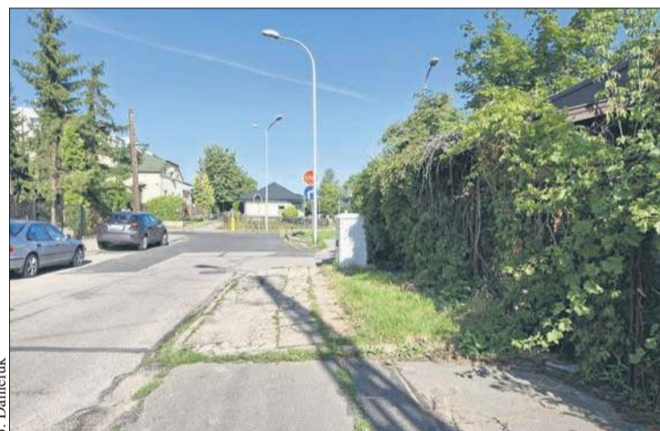
Część ulicy Lasockiego wymaga remontu
