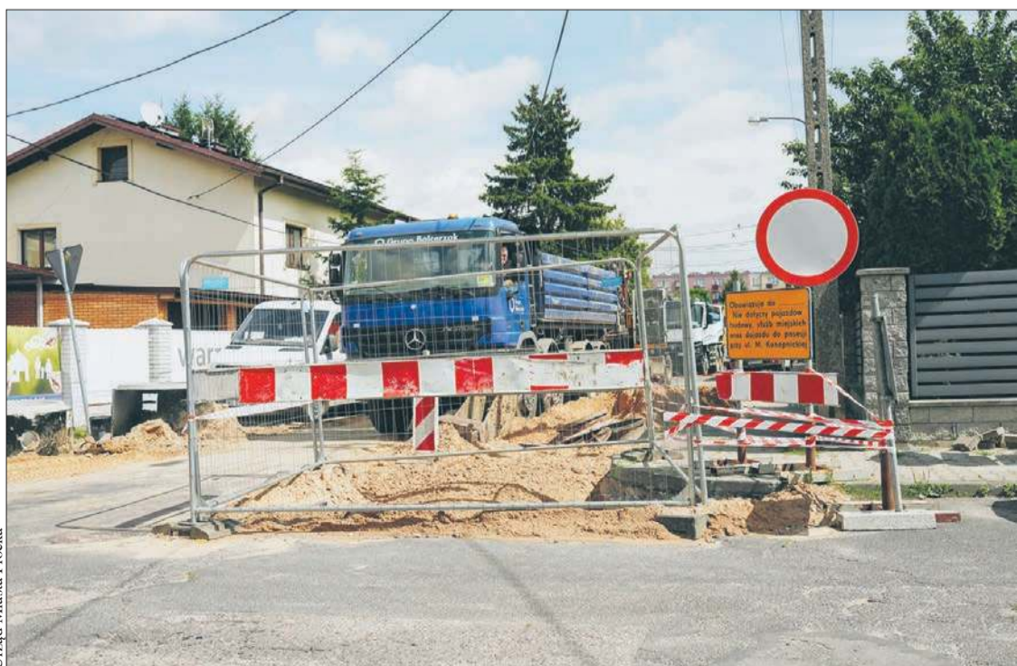
Trwa budowa ulicy Konopnickiej na osiedlu Skarpa
