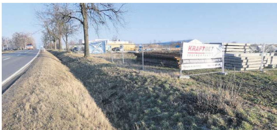
Sąsiadem Leszka Olejarnika od strony miasta jest firma Kraftbet, na terenie której trwają obecnie prace budowlane
