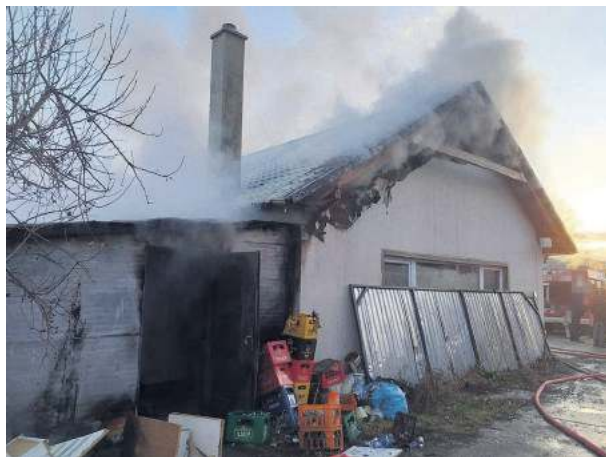
Prawdopodobnie przyczyną pożaru była awaria pieca CO (Foto: Strzelin998)
