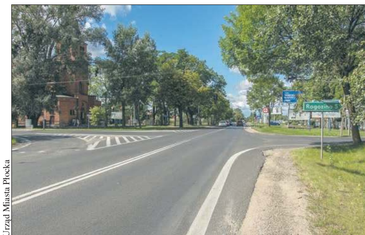
Budowa ronda na skrzyżowaniu w Imielnicy będzie jednym z elementów rozbudowy ulicy Wyszogrodzkiej o dodatkowy pas ruchu
