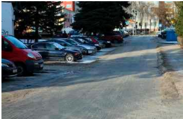
Dzięki oszczędnościom na przetargach miastu udało się wyremontować ulicę Kalinową
