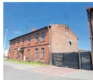
Lokatorzy kamienicy zostali wykwaterowani
