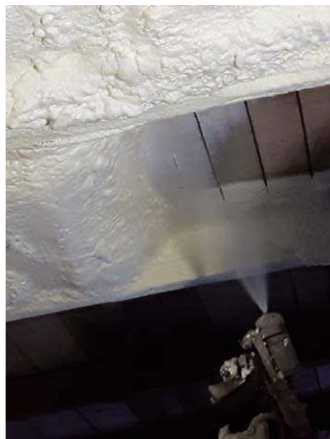
i Do izolacji dachów stosuje się przede wszystkim tzw. piankę otwartokomórkową – bardzo lekką i elastyczną. WWW.PURSYSTEM.PL
