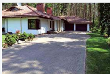
❶ Kostką z betonu wykończono podjazd o długości 30 m, opaskę i ścieżkę wokół budynku.
