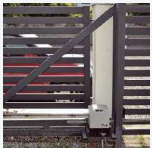
📌 Przeciwwaga bramy i napęd.
