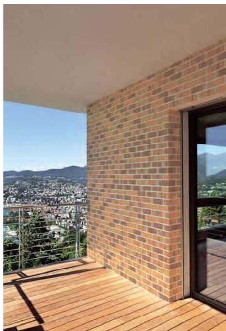
Zastosowanie płytek sprawia, że tańsza ściana dwuwarstwowa może wyglądać jak droższa, trójwarstwowa z cegły klinkierowej. KING KLINKER, WIENERBERGER
