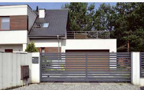
📌 W strefie wjazdowej postawiono z pustaków murki i zamontowano przesuwającą bramę.
