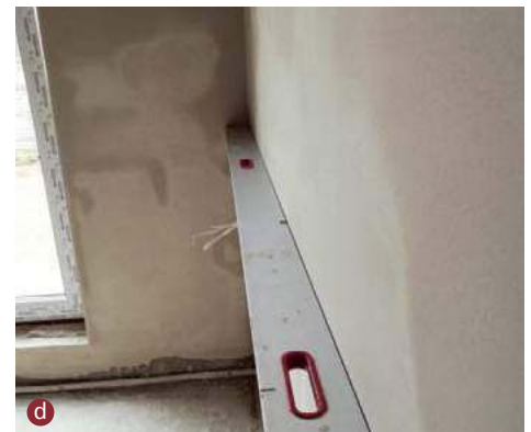
➦ Kolejne etapy wykańczania ścian wewnętrznych z betonu komórkowego tynkiem gipsowym. Gruntowanie podłoża (a), wklejanie siatki tynkarskiej w narożach nad otworami drzwiowymi i okiennymi (b), tynkowanie (c), kontrola wykonanych tynków (d). T. RYBARCZYK
