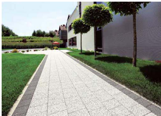
Na ścieżki wybiera się elementy o grubości ok. 4 cm. POLBRUK
