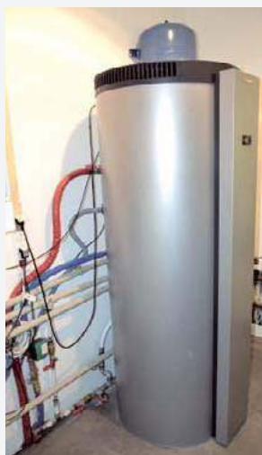
➊ Powietrzna pompa ciepła przygotowuje c.w.u. (ma wbudowany zasobnik o pojemności 300 l).
