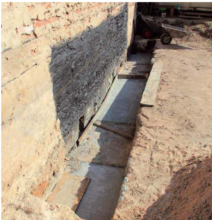
📍 Beton podkładowy pod nową ławę fundamentową zalewany odcinkowo. J.WERNER
