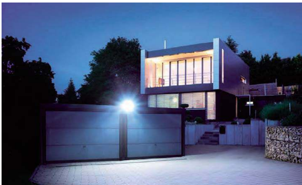
W sąsiedztwie bramy wjazdowej dobrze umieścić silny reflektor połączony z czujką ruchu. Dzięki temu będziemy widzieli, co dzieje się przed naszą posesją. AQUAEL
