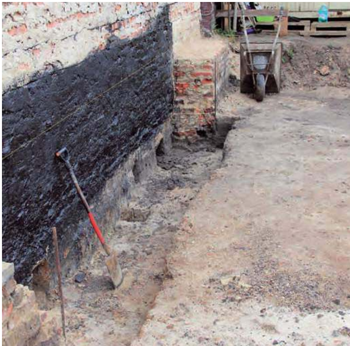
📍 Częściowo odkopane fundamenty sąsiada – docelowo wykop będzie pogłębiany odcinkami o długości 1–1,5 m. J.WERNER
