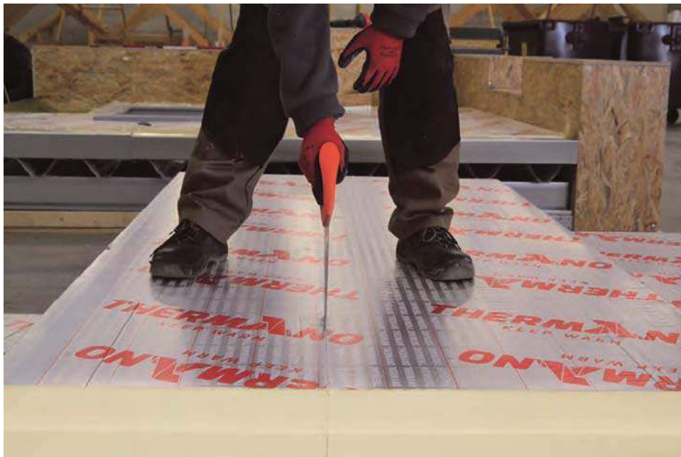
i Płyty z twardej pianki zamkniętokomórkowej trzeba docinać. To bardzo dobry materiał, jednak sposób jego układania jest zupełnie inny. BALEX METAL (THERMANO)
