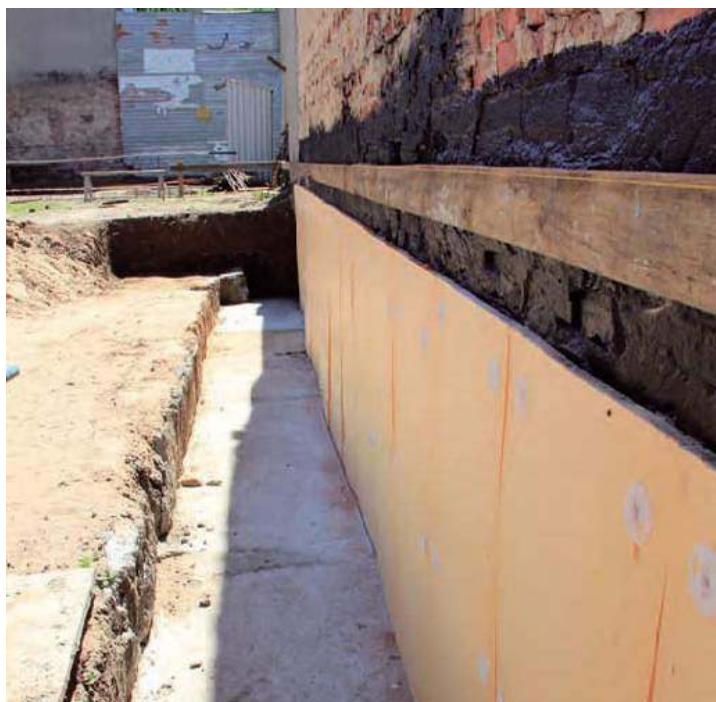
📍 Beton podkładowy gotowy, na ścianie sąsiada dylatacja ze styroduru. J.WERNER
