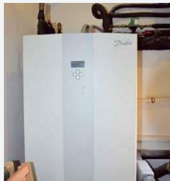
🔌 Grunтовая pompa chłodzi też powietrze w pomieszczeniach.
