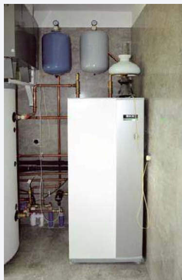
🔧 Gruntowa pompa ciepła o modułowanej mocy grzewczej 4–16 kW i jej oprzyrządowanie.
