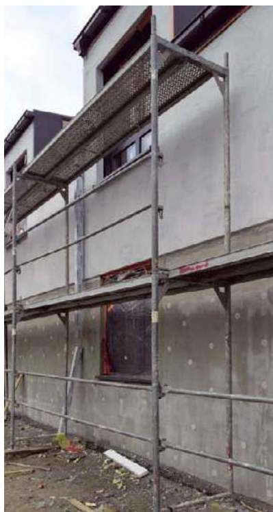
🔧 Wykonanie elewacji domu zbudowanego z bloczków z betonu komórkowego, ocieplonych wełną mineralną. Największą powierzchnię ścian pokrywa tynk cementowo-wapienny. Funkcję dekoracji pełni okładzina z kamienia i drewna. T. RYBARCZYK
