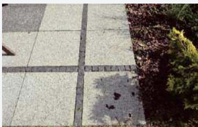
● Płyty z posypką mineralną oraz kostkę ułożono na minimalną fugę.
