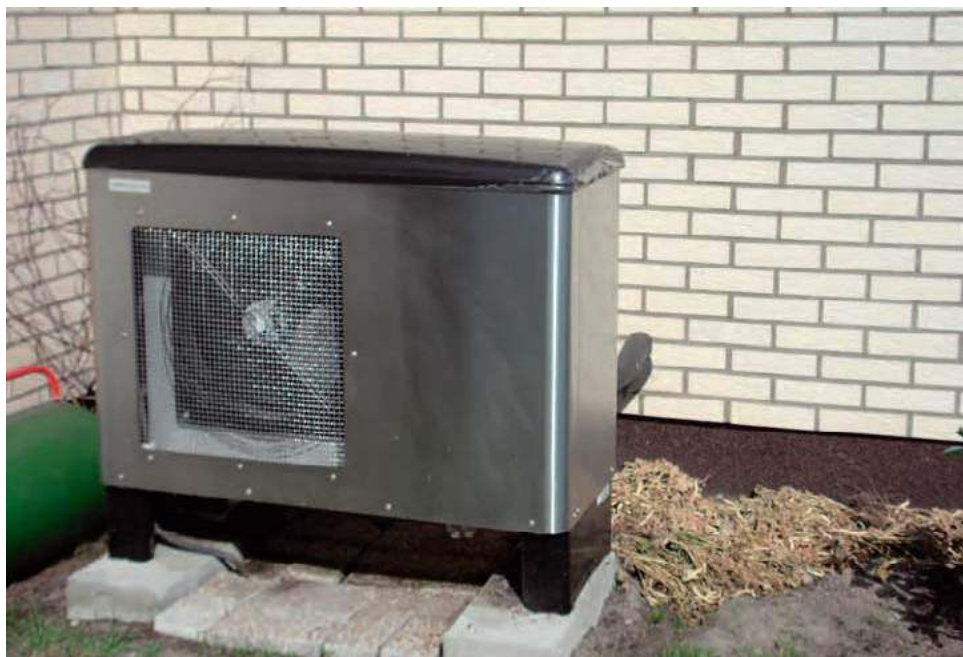
❶ Pompa ciepła do działania potrzebuje prądu. Nadmiar energii z paneli oddany do sieci latem zasili ją w zimie. NIBE-BIAWAR
