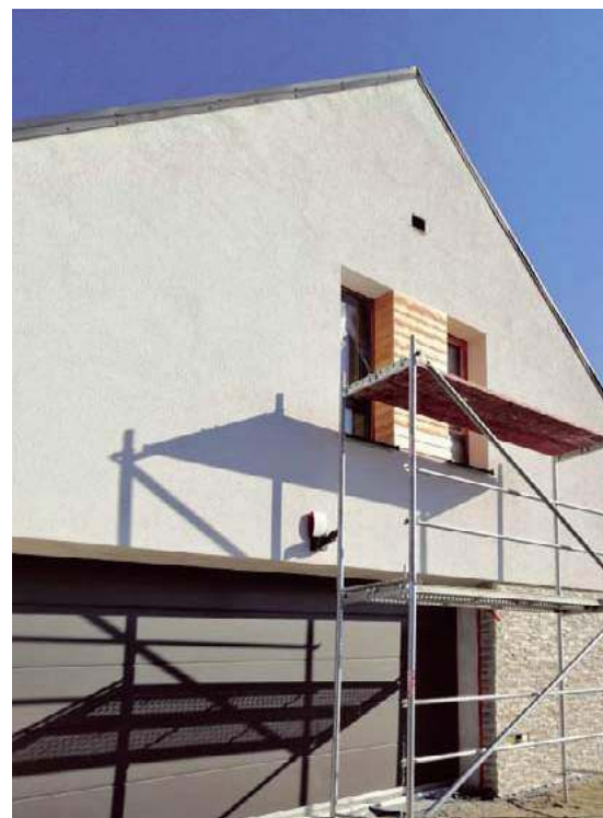
🔧 Wykonanie elewacji domu zbudowanego z bloczków z betonu komórkowego, ocieplonych wełną mineralną. Największą powierzchnię ścian pokrywa tynk cementowo-wapienny. Funkcję dekoracji pełni okładzina z kamienia i drewna. T. RYBARCZYK
