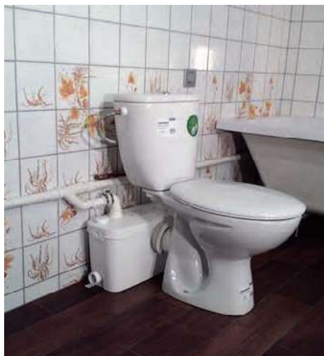
Pomporozdrabniacz, nazywany także młynkiem, odprowadzi do góry również ścieki z fekaliami. WILO
