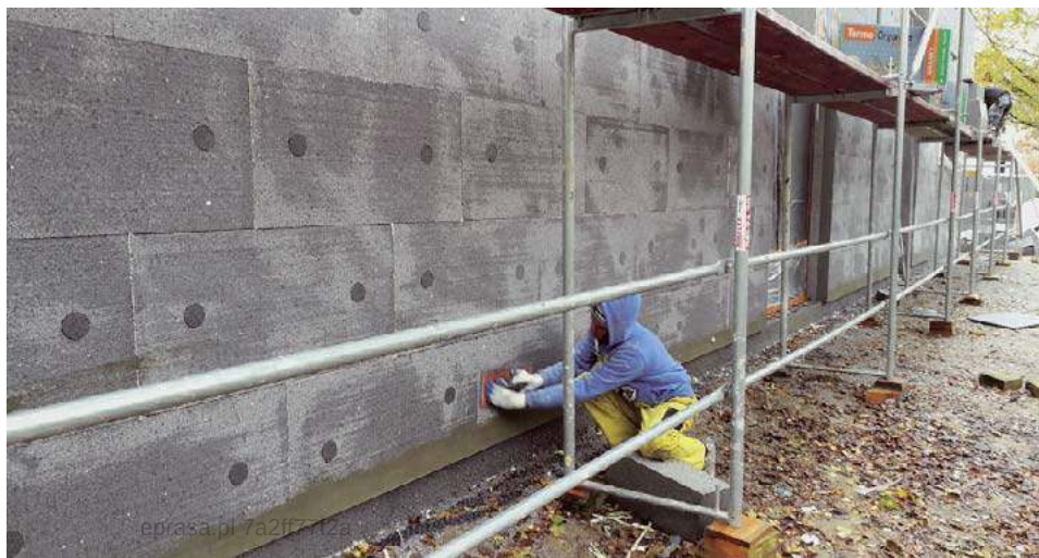
🔧 W przypadku ocieplenia ścian z betonu komórkowego styropianem można zastosować dowolny tynk. T. RYBARCZYK
