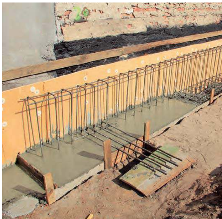
📍 Zbrojenie ławy fundamentowej zalewane betonem. Widoczne startery pod ławy poprzeczne, prostopadłe do granicy działek. J.WERNER
