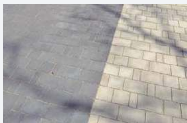
🔍 Kostka w dwóch odcieniach szarości ma płaską powierzchnię i lekko pofalowane brzegi, między nimi – cienka fuga z piasku.
