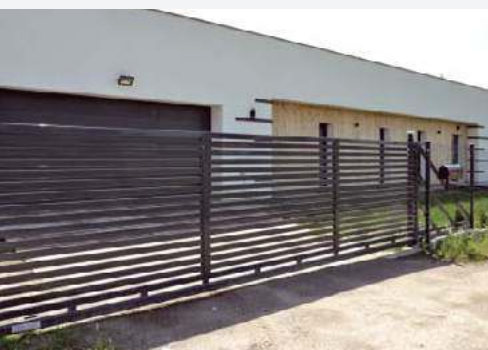
❶ Jednoskrzydłowa brama ma szerokość aż 6 m (plus przeciwwaga). Obsługuje ją mocny napęd i 4 czterokanałowe piloty.
