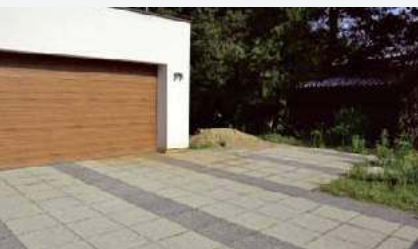
● Z płyt betonowych ułożono podjazd do garażu i miejsce parkingowe pod chmurką.
