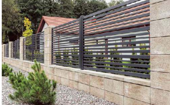
❸ Zastosowanie elementów prefabrykowanych znacznie przyspiesza wykonanie ogrodzenia. JONIEC
