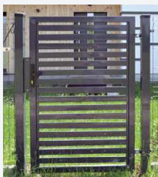
❷ Furtkę o szerokości metra (i bramę) wykonano ze stali wyprofilowanej na „deskę”
