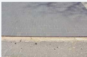
🔍 Na granicy z asfaltem położono szeroki krawężnik z betonu.
