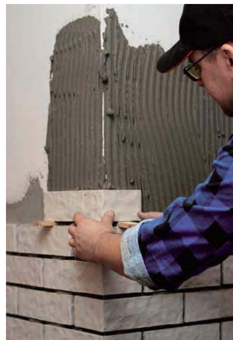
Zastosowanie płytek sprawia, że tańsza ściana dwuwarstwowa może wyglądać jak droższa, trójwarstwowa z cegły klinkierowej. KING KLINKER, WIENERBERGER
