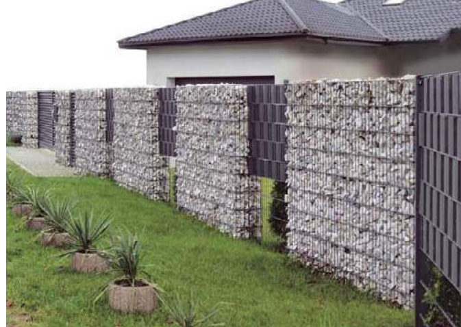
📌 Ogrodzenie z koszy gabionowych można łączyć z dowolnym typem przęseł i słupków. KONSORT
