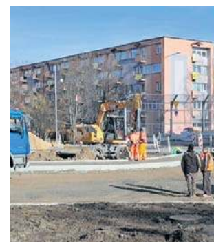
Prace przy budowie ronda turbinowego w Radomiu.
