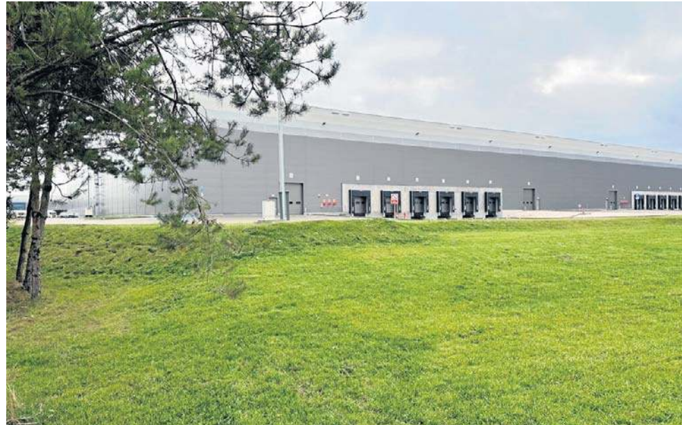
Hala na radomskim Wincentowie. Teren należy do specjalnej strefy przemysłowej przygotowanej przez miasto Radom.
