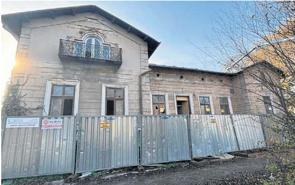
Trwają prace remontowe zabytkowej Willi Zabiełły przy ulicy Okulickiego w Radomiu.
