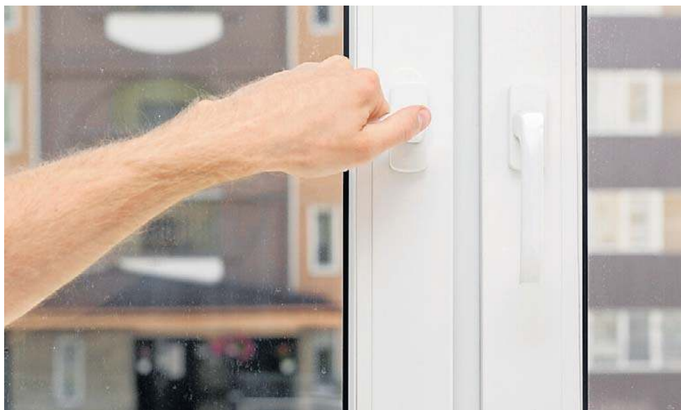
Zaparowane okna świadczą o problemie z wilgocią, dlatego trzeba regularnie wietrzyć. Nawet zimą
