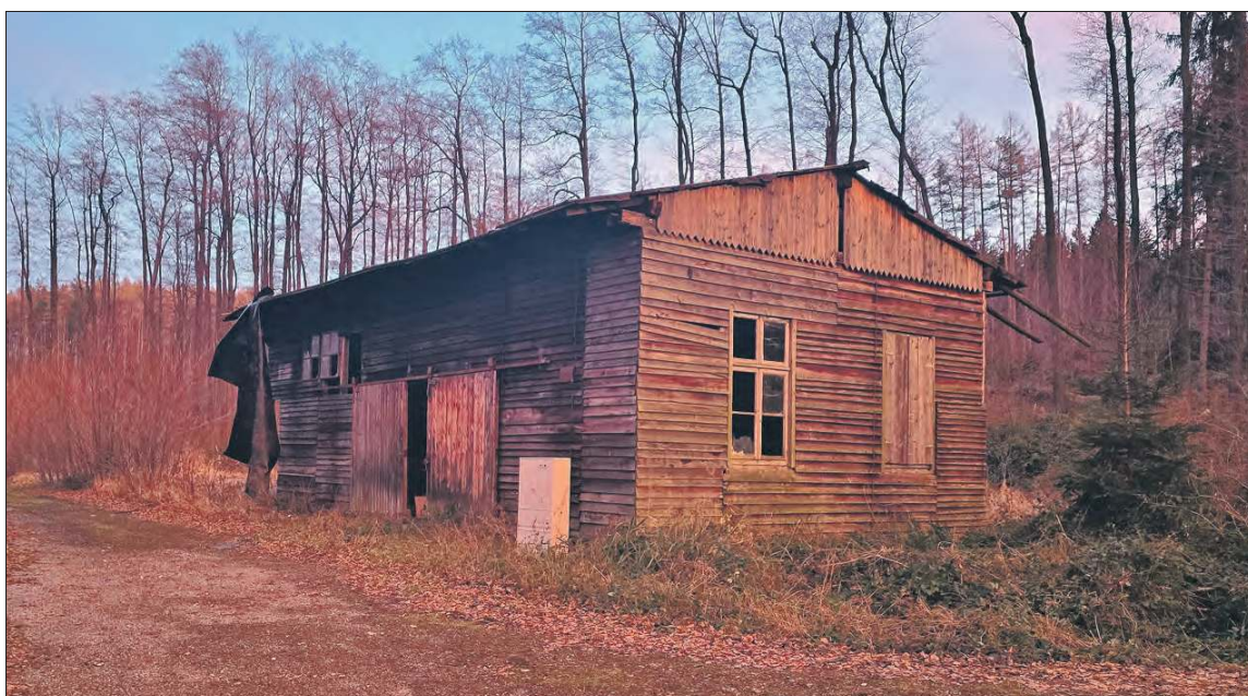
Część budynków ma lekką, drewnianą konstrukcję
