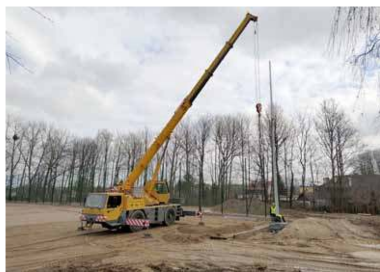
W środę trwało montowanie masztów oświetleniowych
