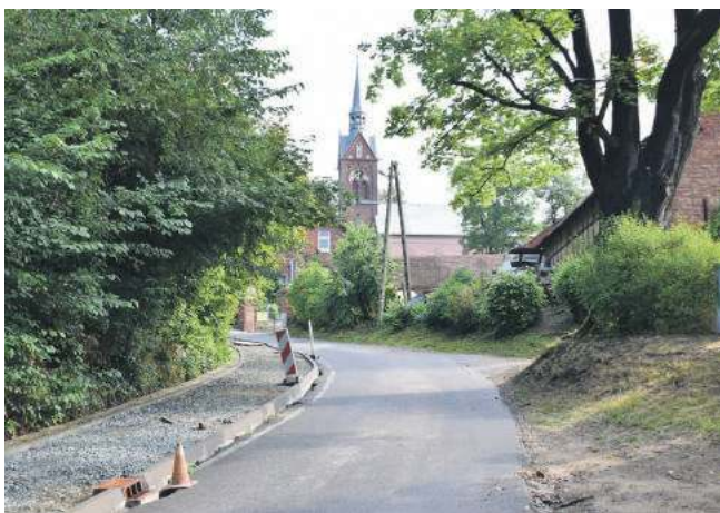
W Wysokim Kościele trwa budowa chodnika na ulicy Zacisze
