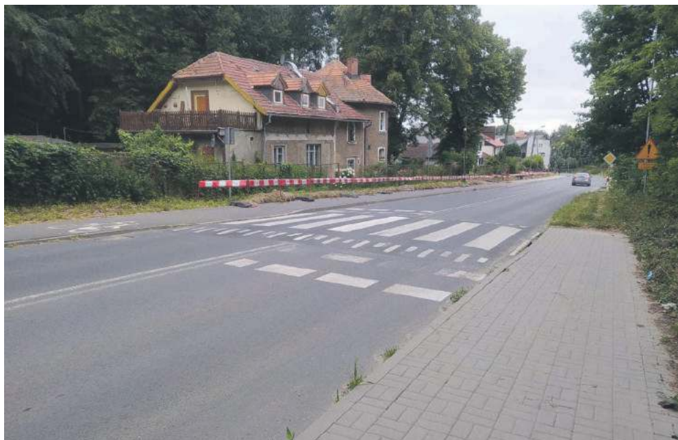
Wyniesione przejście dla pieszych przy na Oleśnickiej
