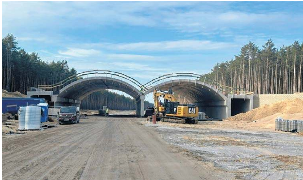
Tak wyglądał odcinek S10 Solec Kujawski - Toruń Zachód w lutym tego roku. Stan zaawansowania prac, jak podaje GDDKiA, to ponad 45 procent
