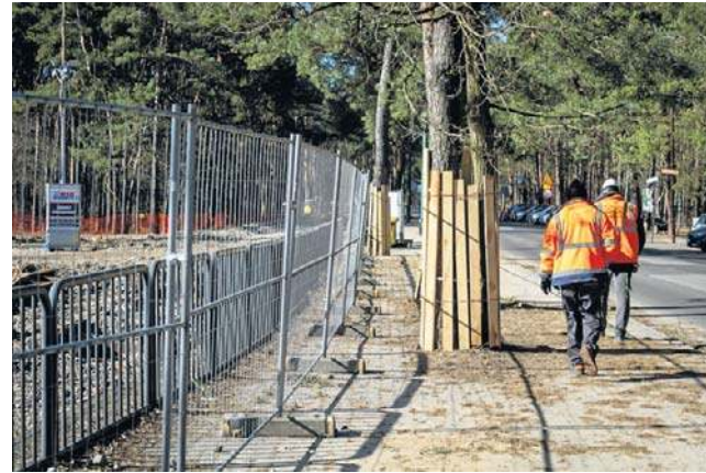
Prace przy pętli Las Gdański trwają od początku stycznia
