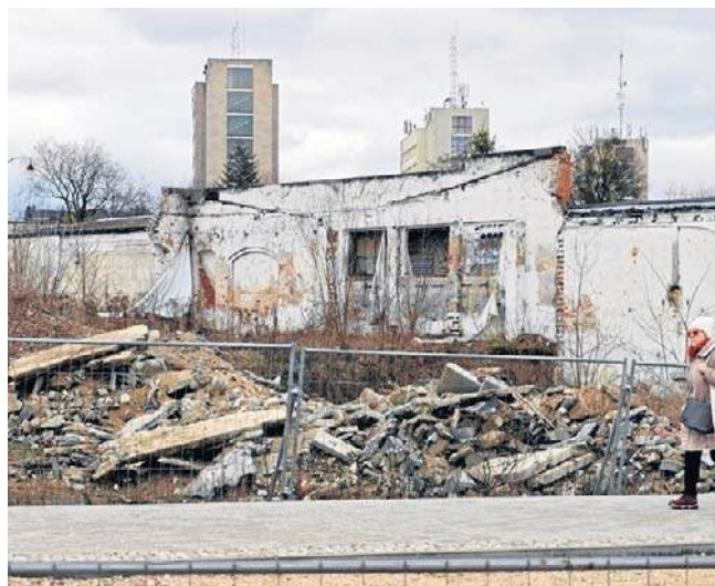
Kolejny rok już straszy to gruzowisko w centrum Torunia - to resztki po rozbiórce warsztatów
