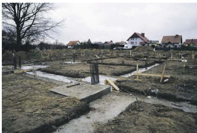
Trwają prace przy budowie nowoczesnej Szkoły Podstawowej im. Lecha i Marii Kaczyńskich w Skokowej
