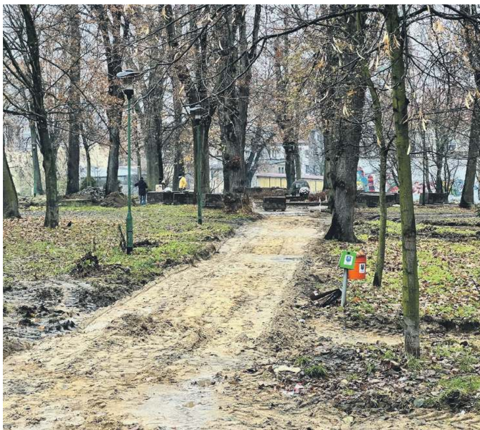
Rewitalizacja ma kosztować ponad 3 mln zł. ile dokładnie? To będzie wiadomo dopiero po zakończeniu wszystkich prac
