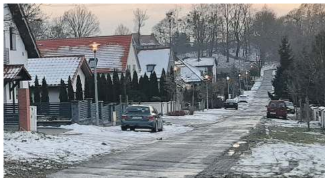
Za wcześnie włączające się oświetlenie na ul. H. Pobożnego w Obornikach
