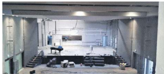
Sala widowiskowa ZDK w trakcie remontu (fot. ZDK)
