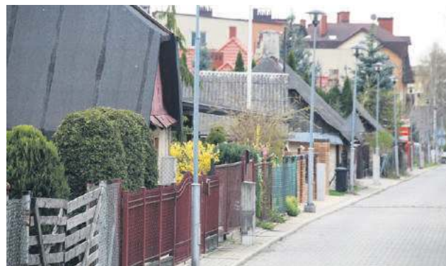
Dachy domów przy ul. Zacisze
