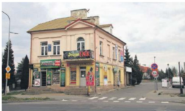
Murowana kamienica przy skrzyżowaniu ulic: Zacisze i Partyzantów
