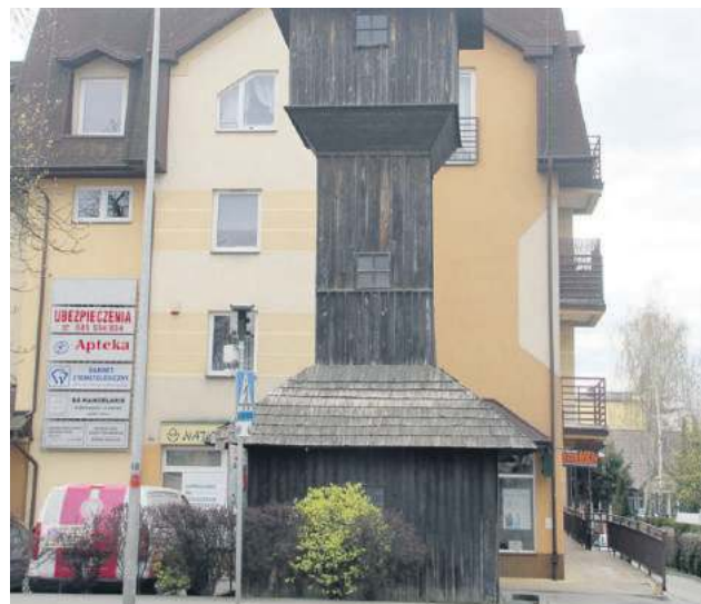
Drewniana wieża ciśnień w sąsiedztwie ulicy Zacisze
