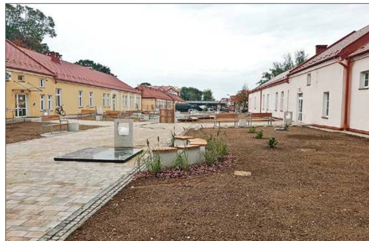
Ogród, a właściwie plac, czeka już tylko na odbiory techniczne.
