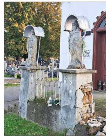
Figury przy kaplicy w Przeczycy wymagają natychmiastowych prac.
