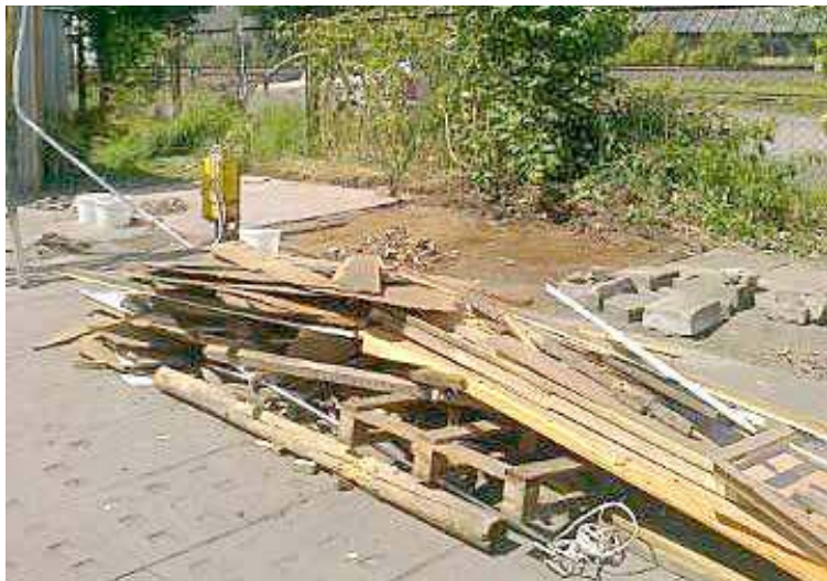
Zdjęcie wykonane już po rozebraniu pawilonu z rybami
