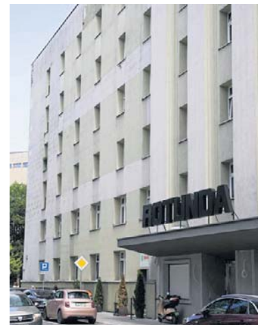
W Centrum Kultury Rotunda trwa wielki remont
