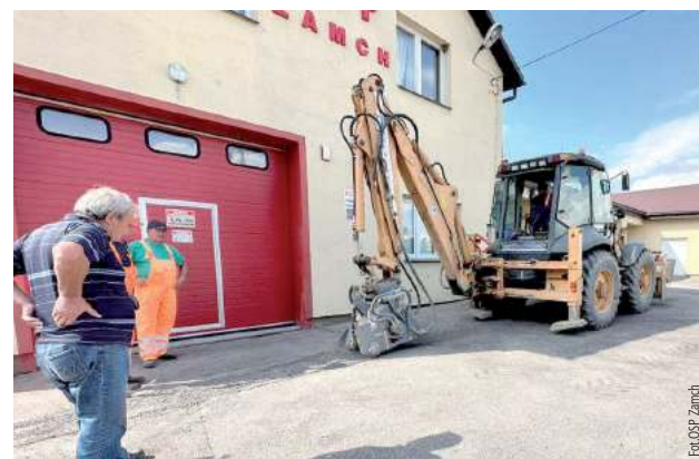
Nowy podjazd przed remizą w Zamchu już gotowy
