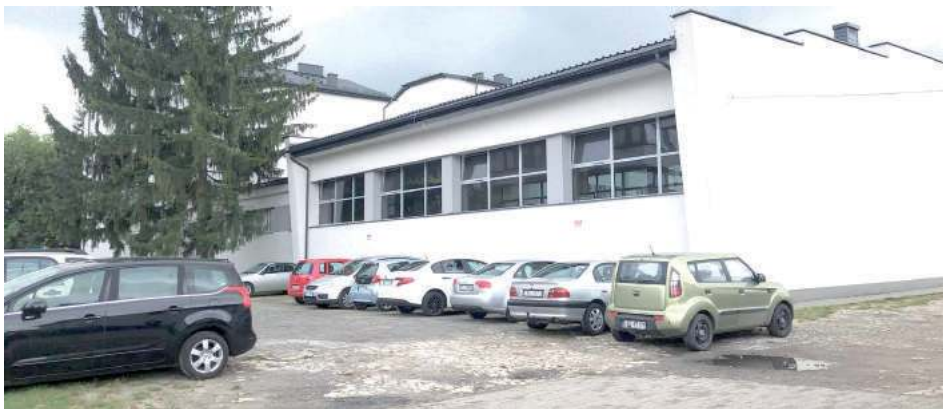
Nowa sala gimnastyczna ma powstać w miejscu parkingu i zostanie dobudowana do istniejącej już sali
