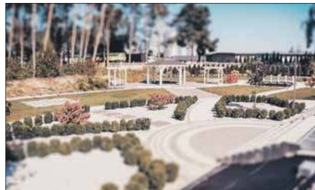
Kompleks hotelowo-restauracyjny to również piękny, duży ogród utrzymany w stonowanych kolorach
